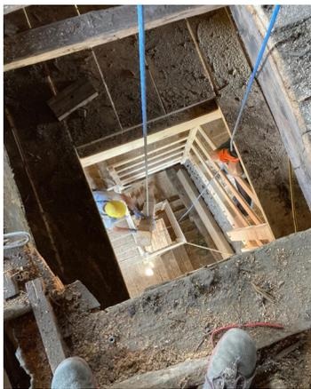
Mittlerweile konnten auch der Stiegenaufgang zum Turm und der Glockenstuhl fertig gestellt und das schadhafte Holz beim Kirchturm ausgetauscht werden.
