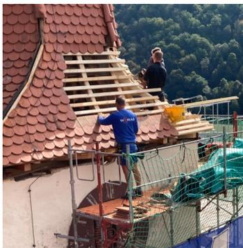
Damit in Zukunft kein Wassereintritt mehr möglich ist, wurden die Gratsparren mit Blechabdeckungen ausgeführt (von außen nicht sichtbar). Sämtliche Sanierungsarbeiten wurden in Abstimmung mit dem Denkmalamt und dem Baureferat der Diözese ausgeführt und von einem Statiker begleitet.
